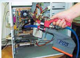
Aspiración de polvo fino en ordenadores y cuadros eléctricos
